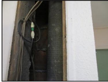
Photo N° 645 AMIANTE CIMENT -- GAINTE TECHNIQUE eau usé - RDC Gaines & coffres verticaux Chute E.U.(Fibres-ciment)
